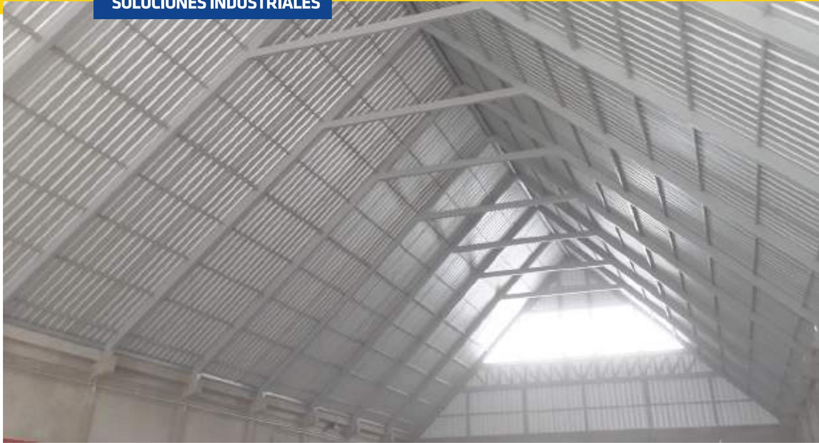
Soluciones en galpones listos para montar en campo, que permiten hasta un 90% de ahorro de tiempo de montaje en comparación con un galpón tradicional debido a la eliminación de soldadura en el sitio de la obra.
