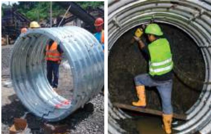
Son planchas livianas de acero corrugado que se ensamblan por el interior del túnel a medida que se realiza la excavación, proporcionando seguridad a los trabajadores y al mismo tiempo constituyéndose en una estructura de soporte. Esta metodología de trabajo permite **NO INTERRUMPIR** o restringir el tránsito de una carretera, mientras se desarrolla la obra.
