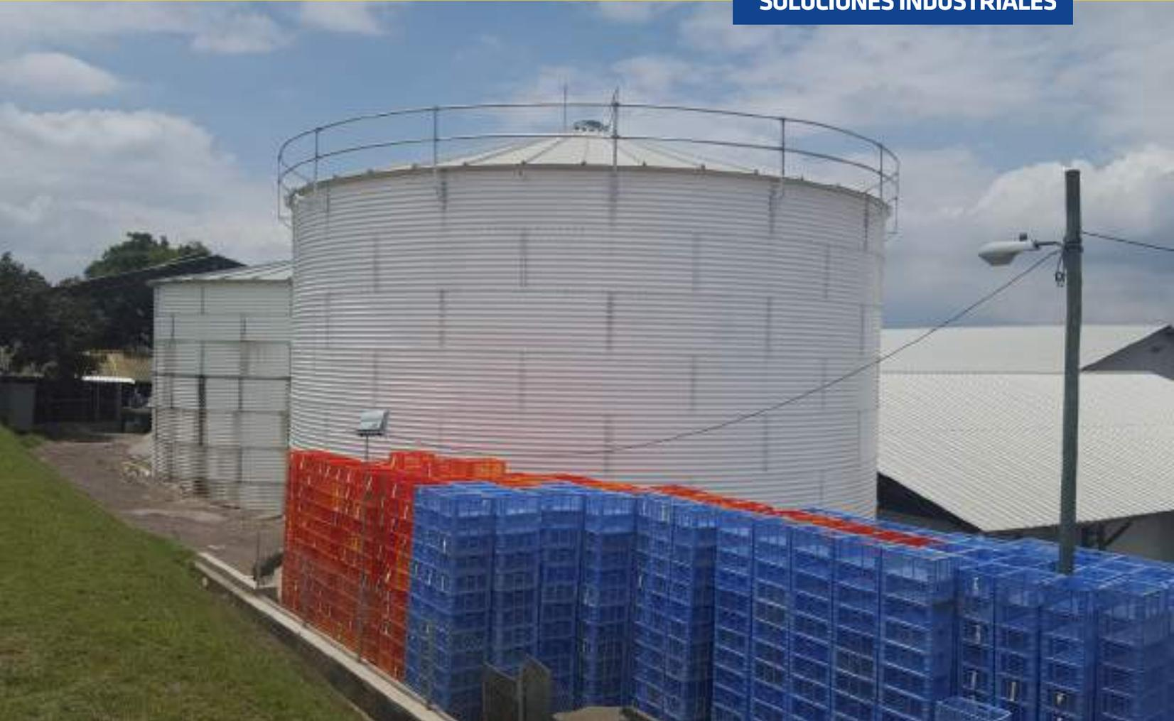
Son diseñados para contener altas capacidades de agua y se los conforma con placas metálicas corrugadas de doble revestimiento (epóxico sobre galvanizado) para utilizarlos en cualquier ambiente.
