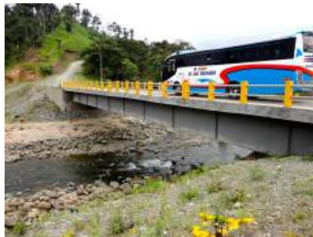
Estos puentes son fabricados con vigas metálicas tipo "I", conformadas en frío en acero A588 ó en A36, sobre las cuales puede descansar un piso metálico o de hormigón armado para conformar la carpeta de rodadura. El "Suministro de Acero A588", la "Fabricación de Vigas" y el "Montaje de las vigas", son los rubros más importantes que se consideran en la construcción de la Superestructura del PUENTE METÁLICO MIXTO.
