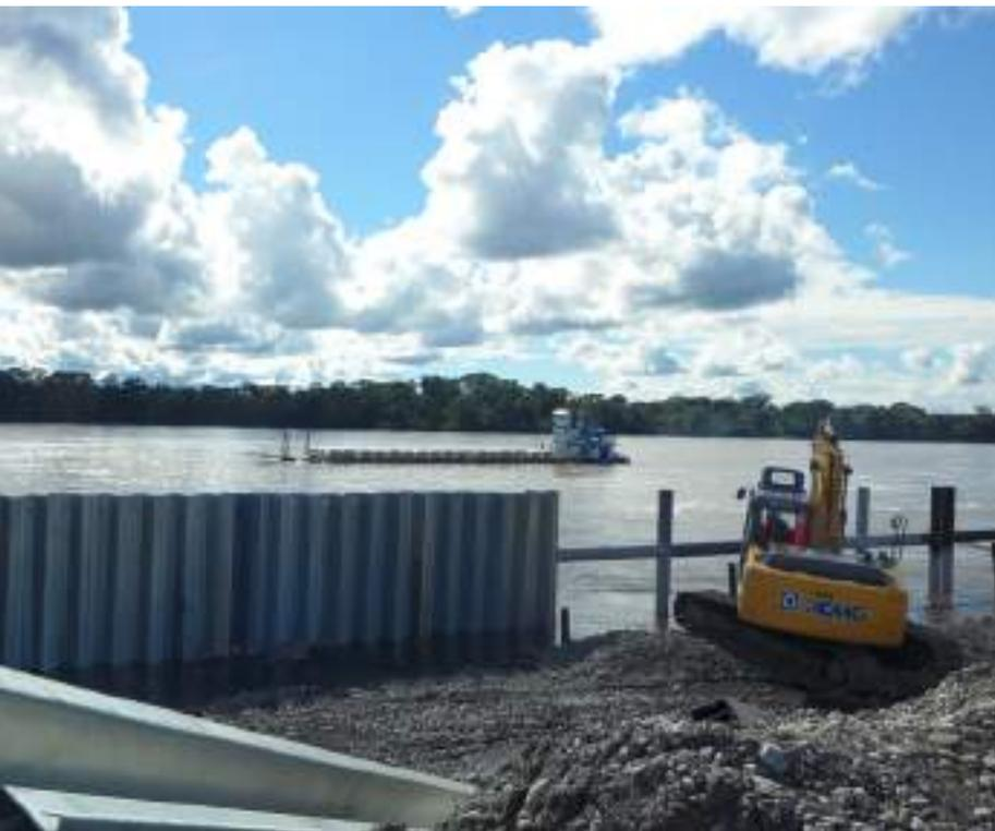
Las tablestacas metálicas de acero se utilizan para contener en forma permanente o temporal tierra, permitiendo además que puedan ser reutilizadas para trabajos de mantenimiento o construcción.
