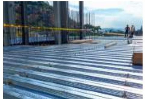
**USOS:** Entrepisos de estructuras metálicas entrepisos de sistemas mixtos con estructura principal de hormigón y vigas de apoyo metálicas.
