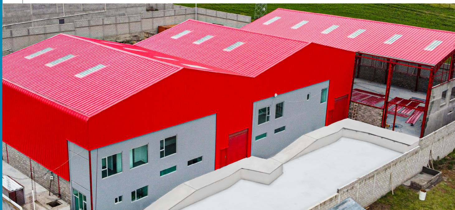
El Prepintado es un recubrimiento que consiste en un proceso de pintura continua sobre una base de galvalume, que incluye limpieza, pretratamiento químico, primer y un acabado de pintura uniforme y especial de tipo poliéster.
