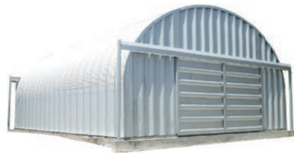
Colocar el material bajo techo
